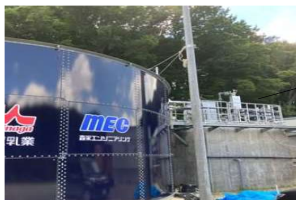
畜産排水処理施設
