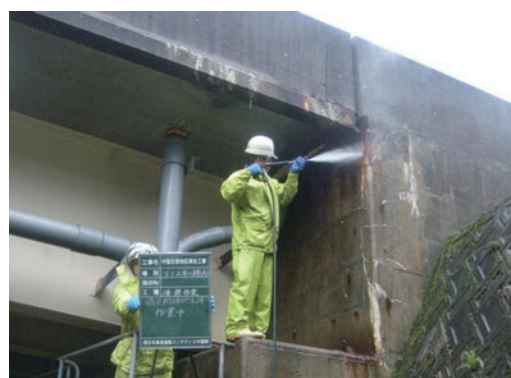
橋梁の桁洗浄風景
