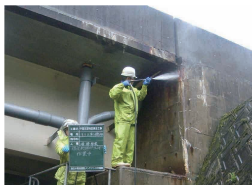
橋梁の桁洗浄風景
