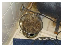
配管内の汚れ
