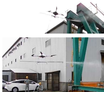
UAV活用による高所の塩分洗浄作業
